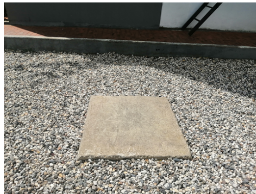
Foto No. 1. Vista general del pozo pz-19-0009.
