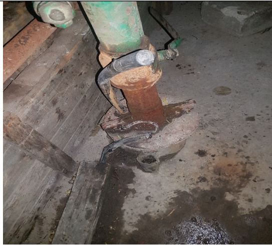
Fotografía 4. Punto para toma de niveles del pozo
